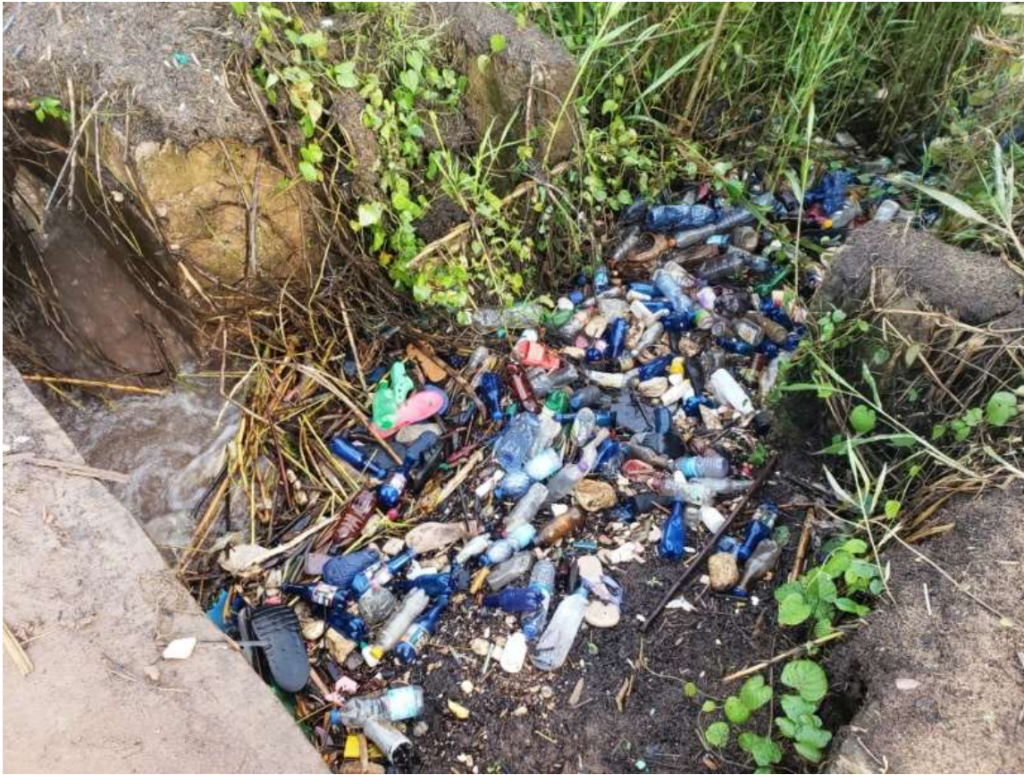
Figure 2: immondices jetés dans les conduites d'eau
